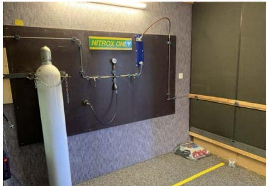
Im neuen Lokal musste die Stromzuleitung erstellt werden. Die Türe musste für das Einbringen des Kompressors verbreitert werden. Die Nitroxanlage wurde installiert und Druckleitungen gezogen.
